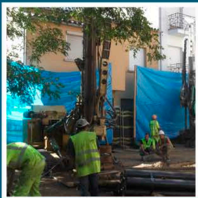
Ejecución de micropilotes
